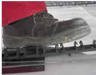
Рис. 15.5-11 Вдавливание фиксирующих шин RAUFIX в конструкцию пола
