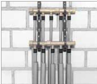
Рис. 15–10 Распределительная гребенка с подвижными гильзами
