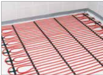
Рис. 15.5-37 Напольная фиксирующая шина для мокрого способа монтажа
