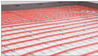
Рис. 15.5-22 Система крепления труб на арматурной сетке
