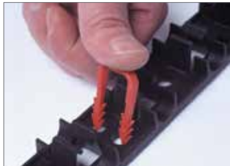
Рис. 15.5-12 Вдавливание гарпун-скоб в конструкцию пола
