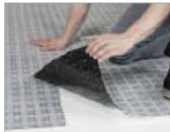
Рулон с минимальным нахлестом 10 см на поперечной стороне
