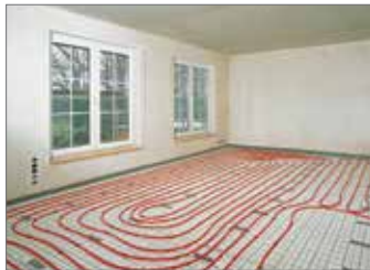
Рис. 15.5-1 Система крепления труб с помощью гарпун-скоб
