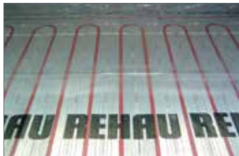
Рис. 15.6-1 Система укладки труб на теплоизоляционных матах TS-14
