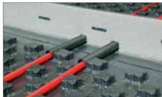
Рис. 15.2-5 Деформационный профиль в матах Varionova
