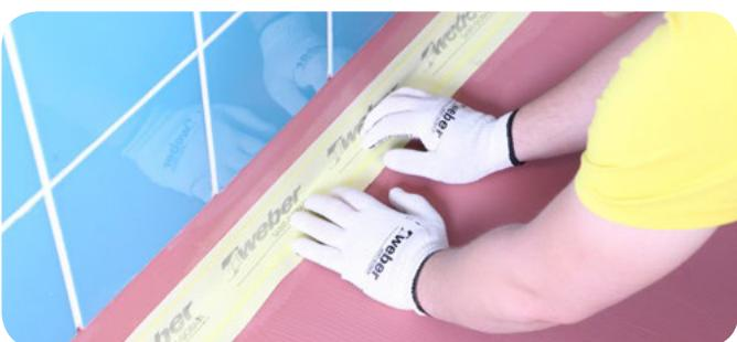
Необходимо нанести не менее 2 слоев: сначала на основание наносится слой розового цвета, а после его высыхания (через 3 часа при +20°C и влажности воздуха 50%) наносится слой серого цвета.
