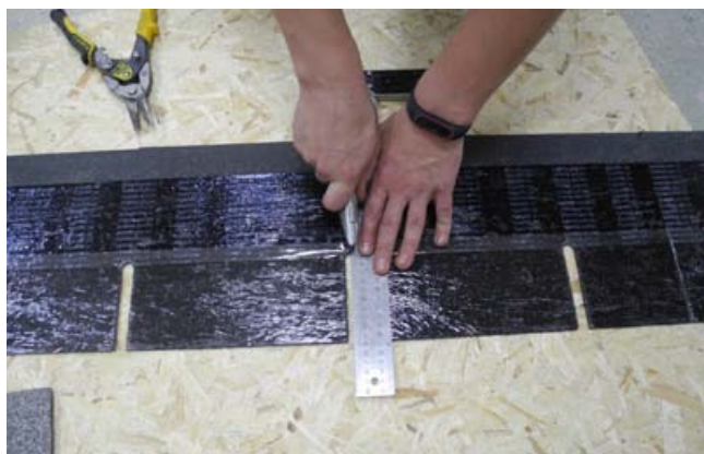
Рис. 13. Деление плитки на лепестки
