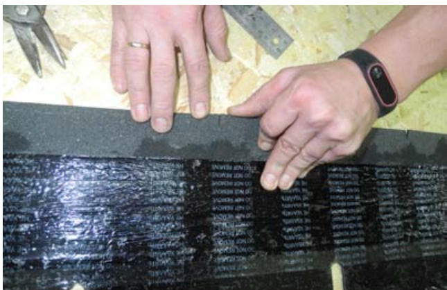
Рис. 12. Насечка для облегчения монтажа
